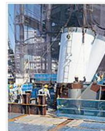
2009年4月6日撮影、地上部最初の塔体鉄骨取付けの様子。この鉄骨は高さ約4m、直径2.3m、厚さ10cm、重さは約29t
